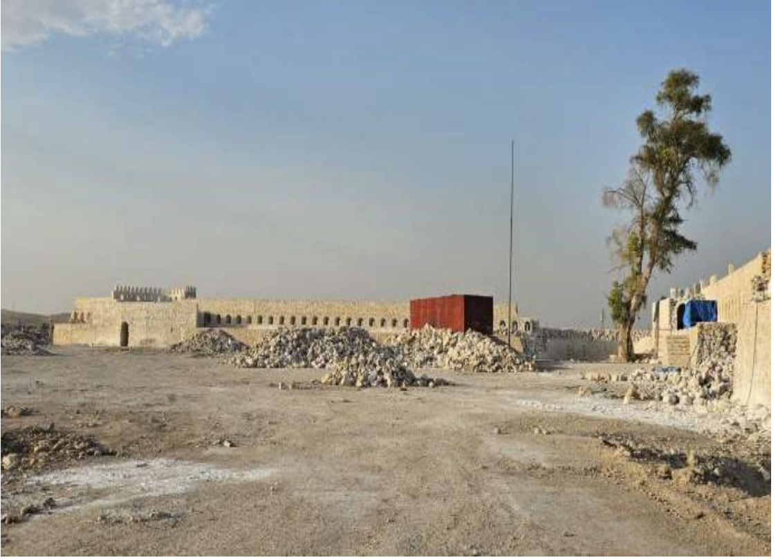
BM İŞBİRLİĞİ – TELAFER KALESİ’NİN RESTORE ÇALIŞMALARI
